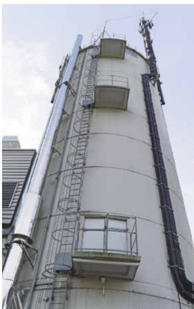
Der Späneturm bei Moser ist jetzt mit neuer Betriebstechnik ausgestattet
