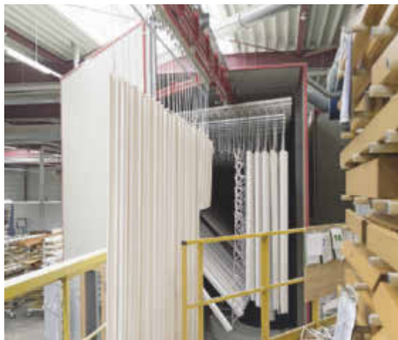
Die neue Betriebstechnik verhindert zu hohe Temperaturen bei der Wasserlackierstraße für Fenster ...
