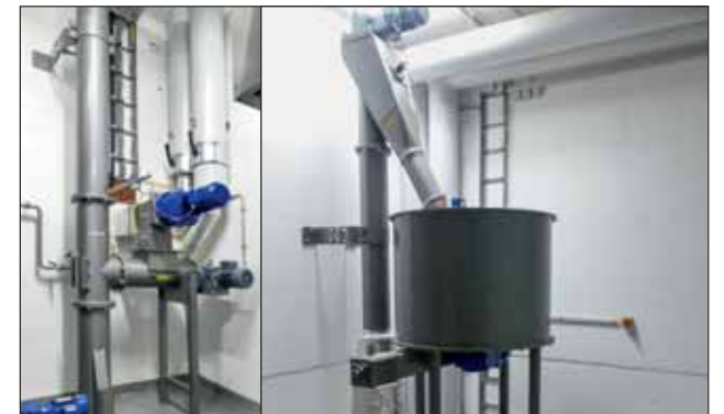
Die Brennstoffförder- und Vorratstechnik ist bereits auf eine mögliche Erweiterung der Anlage ausgelegt.
