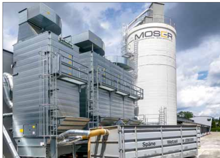
Neue Absaugung und nach dem Brand ertüchtigtes Spänesilo
