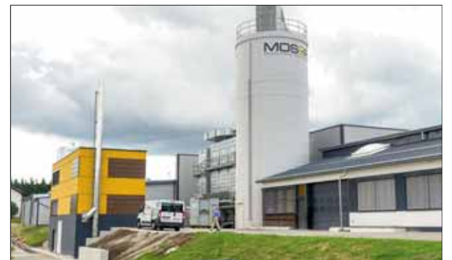
Ein Brand im Silo war Ausgangspunkt der Erneuerung der Wärmeversorgung, einschließlich neuem Kesselhaus (links).
