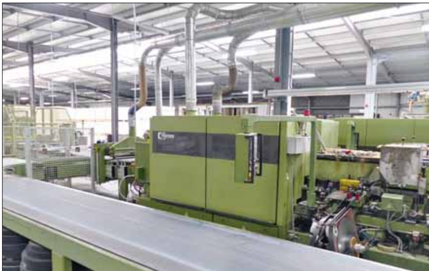
Die Fußbodenheizung sorgt in der Fertigung ...
