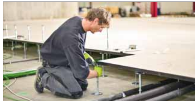
Unter Doppelböden, wie sie Weiss herstellt, verbirgt sich das Versorgungssystem von Büro- oder Computerräumen.
