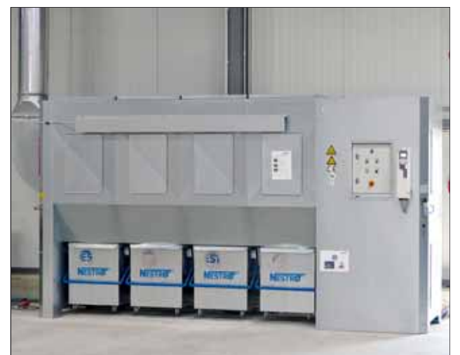
... von einem Mobilentstauber „NE 350 P“ abgesaugt.
