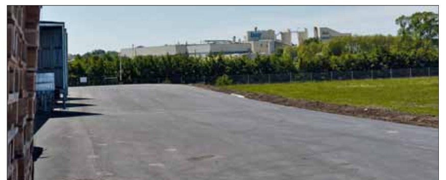
Mit dem Neubau ist man auf Sichtweite zum Lieferanten der Gipsplatten gerückt.
