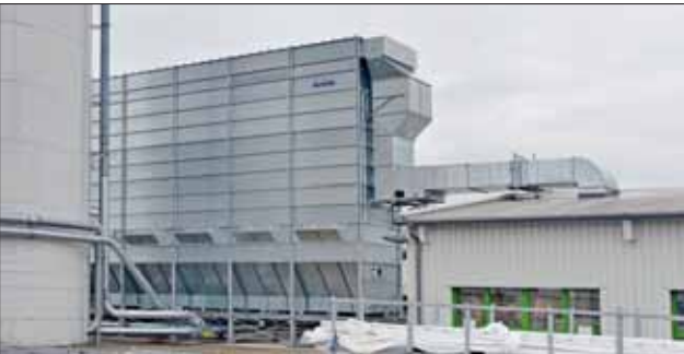
Die „Multistar“-Anlage von Höcker Polytechnik hat eine Stundenleistung von bis zu 250 000 m³ Luft.
