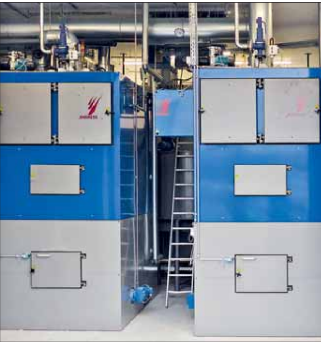
Zur Wärmeversorgung dient nun eine neue Doppelanlage, die die Holzreste aus der Produktion verwertet.
