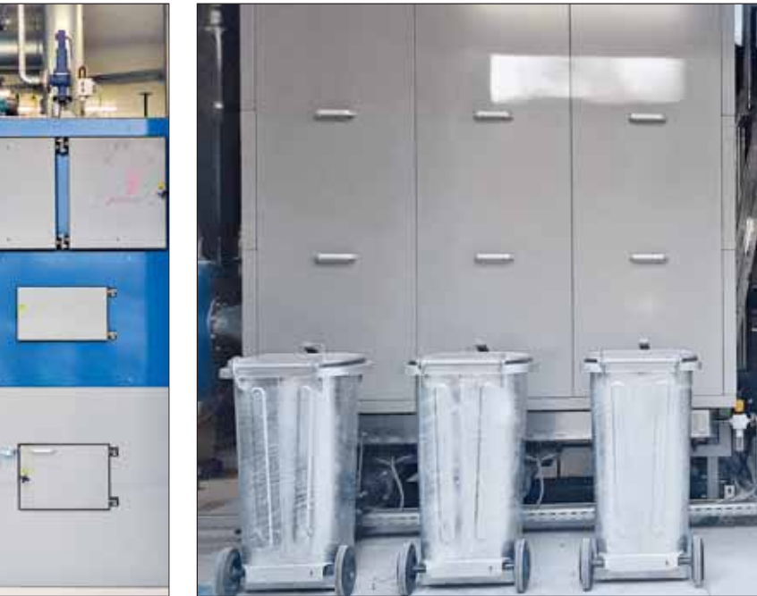
Zur Wärmeversorgung dient nun eine neue Doppelanlage, die die Holzreste aus der Produktion verwertet.
