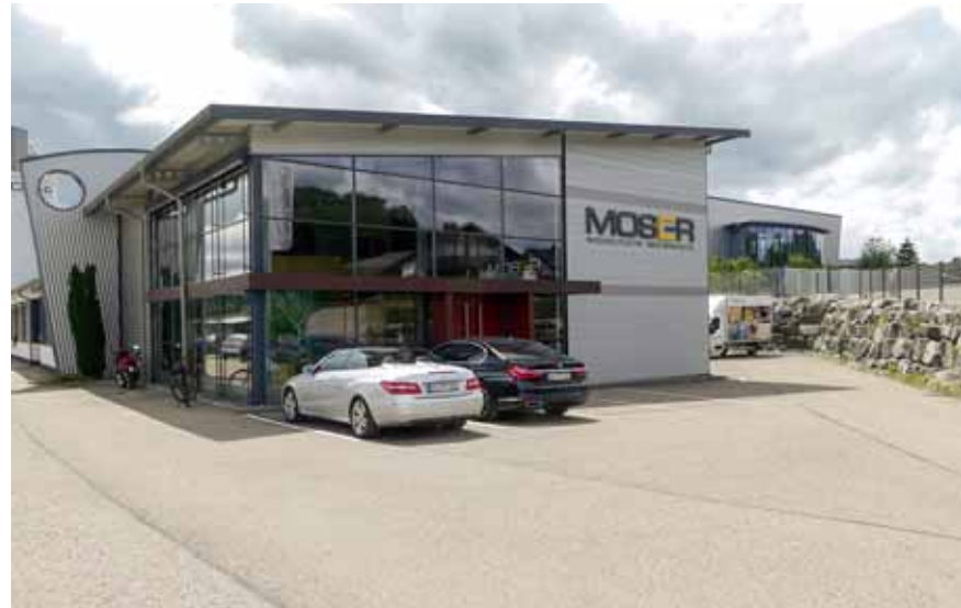
Auch der Büro- und Kundenbereich wurde in letzter Zeit modernisiert ...
