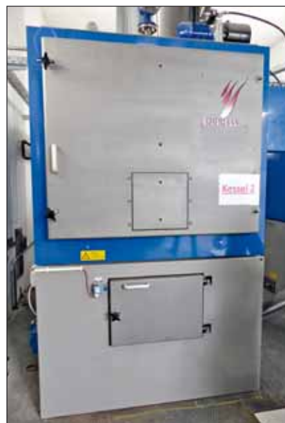
Für das trockene, rindenlose Brennstoffgemisch empfahl Endress seine Unterschubfeuerung. Wichtige Abnehmer der Wärme sind die gerade energetisch sanierten Produktionshallen und der 2014 erneuerte Schnittholztrockner. Hinzu kommen alle Büroräume, die Schlosserei sowie ein Wohnheim für auswärtige Mitarbeiter.
