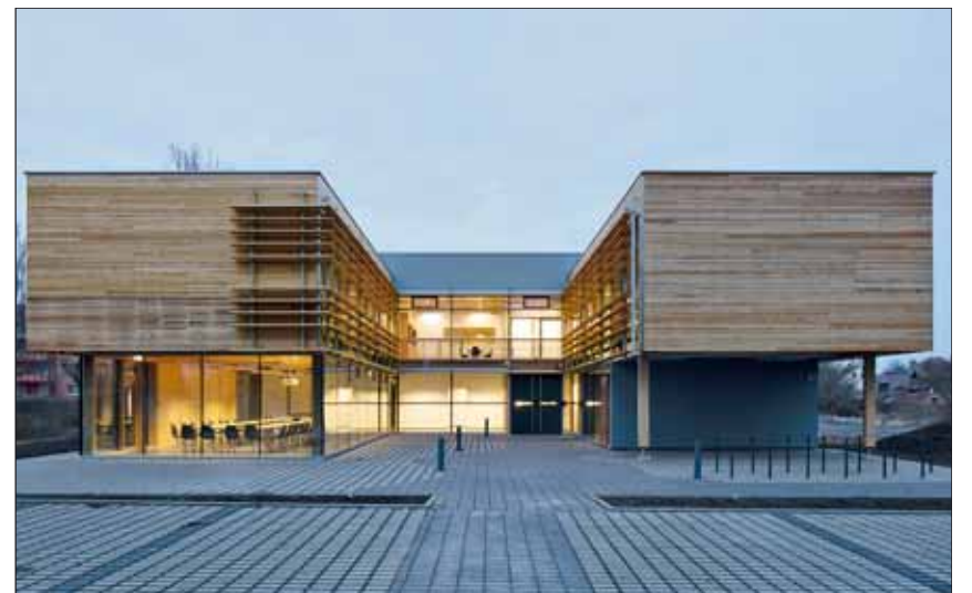
Beim Bau des Forstamtes in Stadtroda wurden Zwischendecken aus Holzbetonverbund mit einer Spannweite bis 6,40 m verwendet. Im Werk in Rosenheim wurden die Furnierschichtholzelemente abgebunden und vor Ort in die Konstruktion eingehoben. Bei dem Bau kam auch Baubuche, als Produkt aus Thüringen, zum Einsatz. Fotos: Grossmann (2), Ißleib
