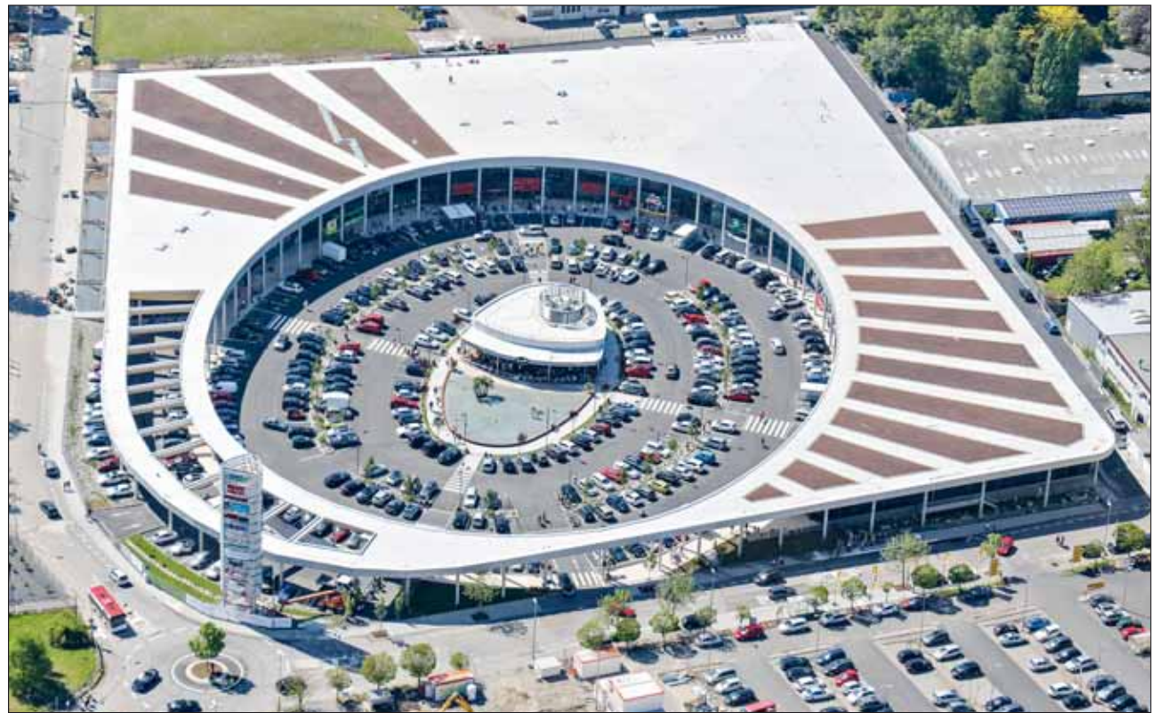
Zu den Großprojekten der letzten Zeit gehört das Einkaufszentrum „Rondo“ in Hanau-Steinheim. Hier wurden bis zu 45 m lange Träger verbaut, die längsten, die bei Grossmann in Rosenheim in einem Stück erzeugt werden können.
