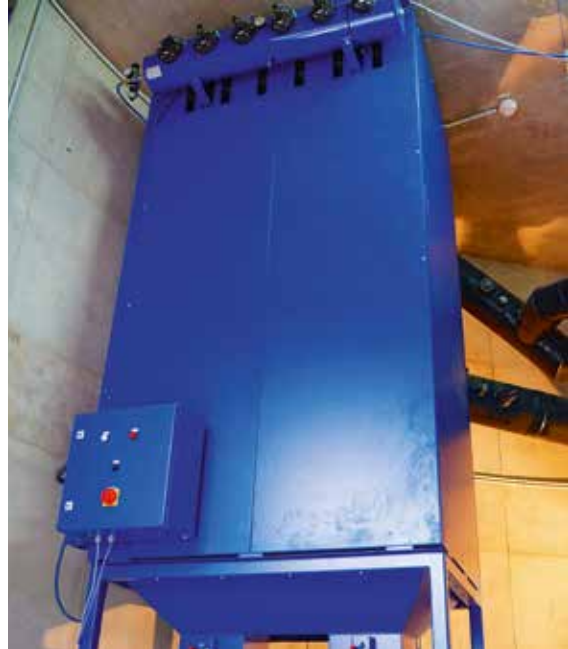
Für den von Endress entwickelten Gewebefilter ist der Staubgrenzwert von 20 mg/m 3 kein Problem
